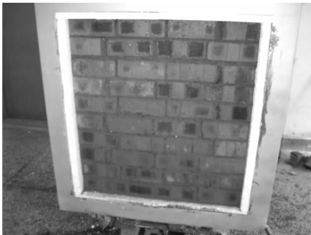
图1 墙体施工过程
