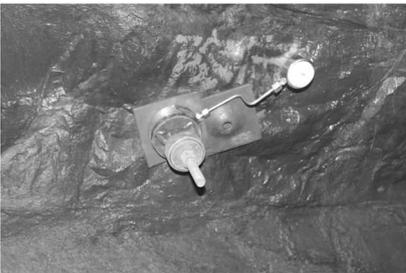
图 6 应用锚杆预紧装置对锚杆进行预紧
