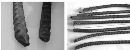
图 1 锚杆剪断失效
