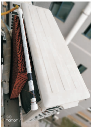
图5 室外机水帘布置
