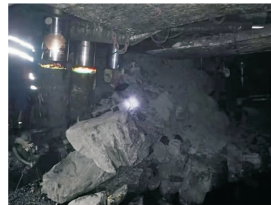
图 2 贯通后工作面漏矸照片
