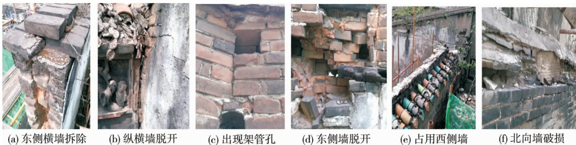
图5 围护结构受损
