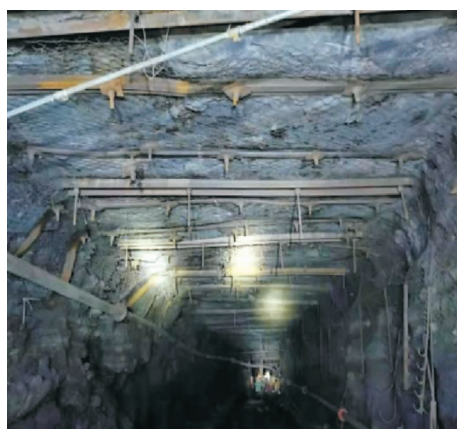
图 17 12110 回风巷道围岩全貌支护效果
